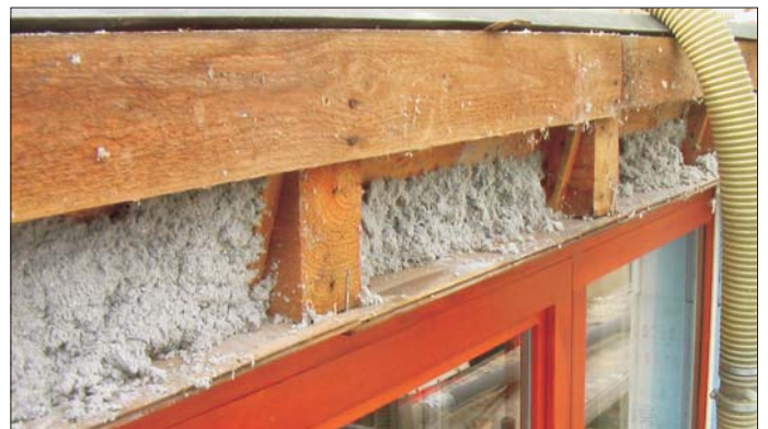
Top in Form: Die Zellulosedämmung schützt vor hohen Energiekosten
