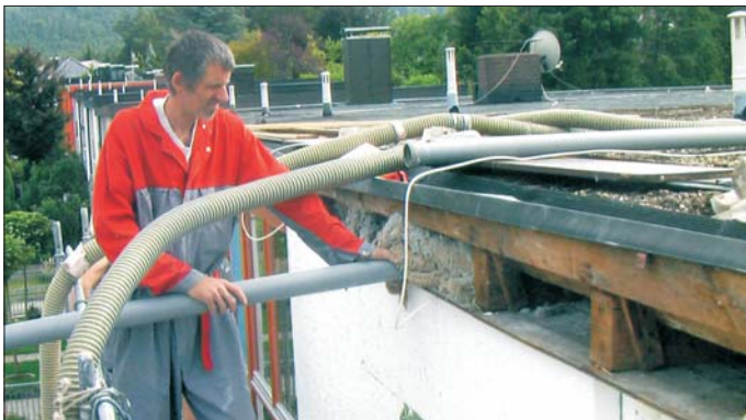
Schnell montiert, kräftig gespart: Der isofloc-Dämmprofi im Einsatz.
