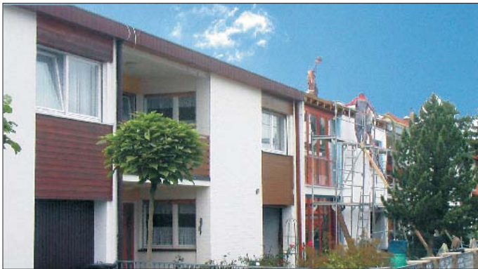
Reihenhäuser aus den 60er Jahren: Die Heizkosten sind enorm
