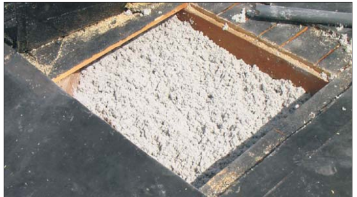
Der Dämmstoff ist vollflächig und dicht eingeblasen
