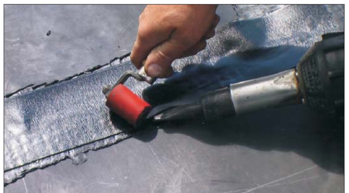
Mit einer überdeckenden Schweißnaht ist das Dach sofort wieder wind- und wetterfest
