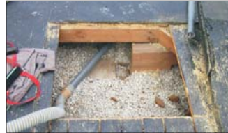
Wenige Einblasöffnungen genügen
